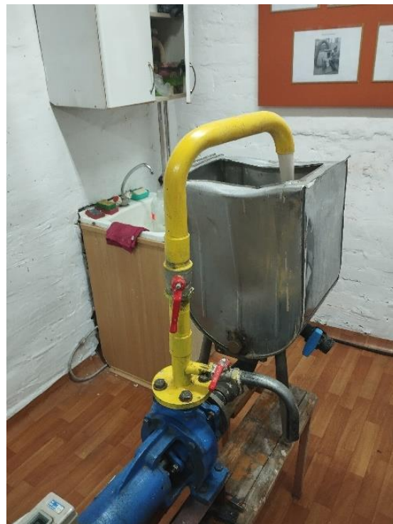
Рисунок 1 – Общий вид установки
