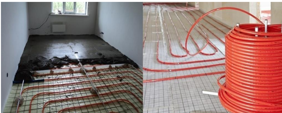
Рис. 3. Укладка теплого пола
