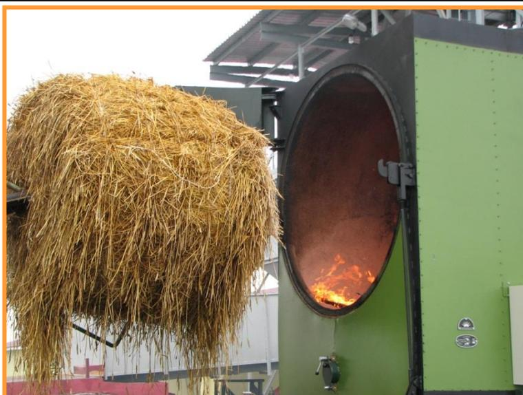
Рис. 2. Газогенераторный котел HERLT HSV 1000 [6]
