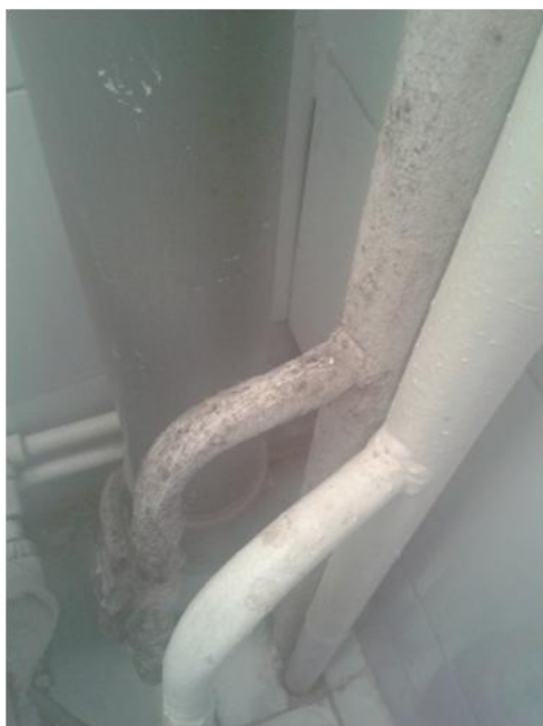
Рис. 1. Водопроводные трубы со следами биоповреждений
