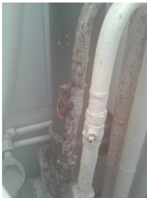
Рис. 1. Водопроводные трубы со следами биоповреждений
