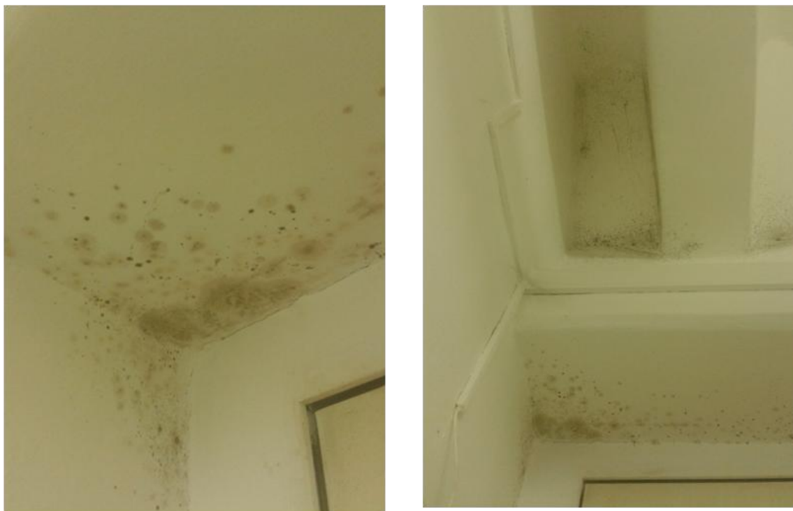
Рис. 2. Стены и потолок с пятнами плесени
