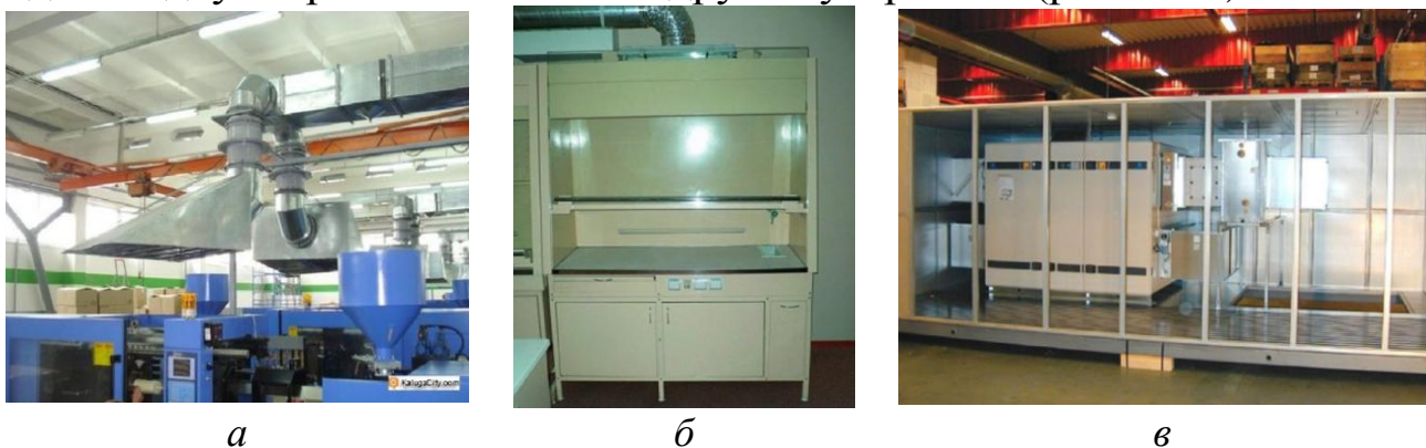
Рис. 3.14. Элементы механической вентиляции: а – вытяжной зонт; б – вытяжной шкаф; в – бокс для удаления высокотоксичных продуктов
