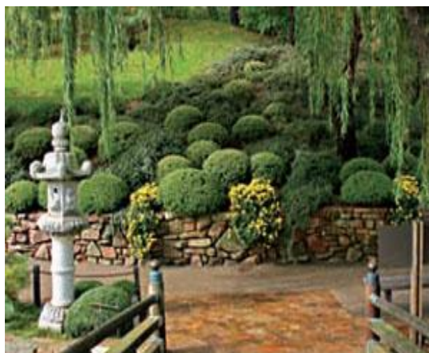
Рисунок 53 – Подпорная стена из камня
