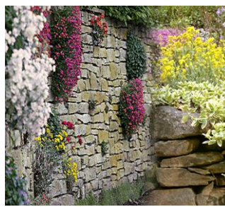
Рисунок 22 – Пример подпорных стен
