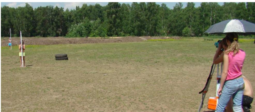
*Рисунок 11 – Нивелировка строительной площадки объекта недвижимости с участие двух речников*
