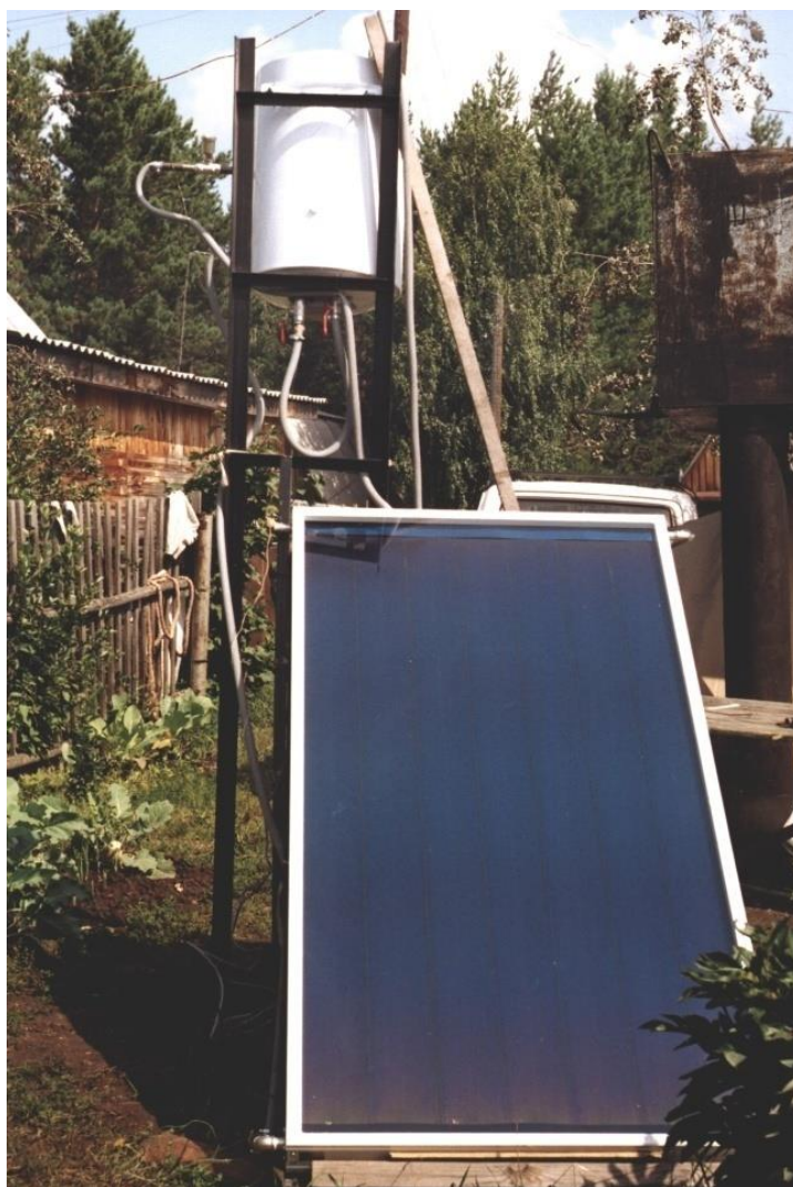
Рисунок 4.2 – Система солнечного горячего водоснабжения на базе гелиоколлектора «Сокол» в садоводстве «Нива» Красноярского государственного аграрного университета
