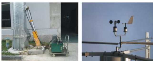
Рисунок 3.14 – Монтаж башни ВЭУ
