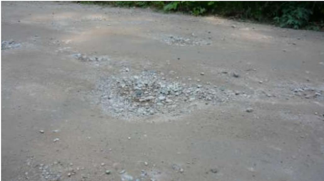
*Рисунок 3 – Суффозионные воронки на дороге вдоль ручья Моховой*
