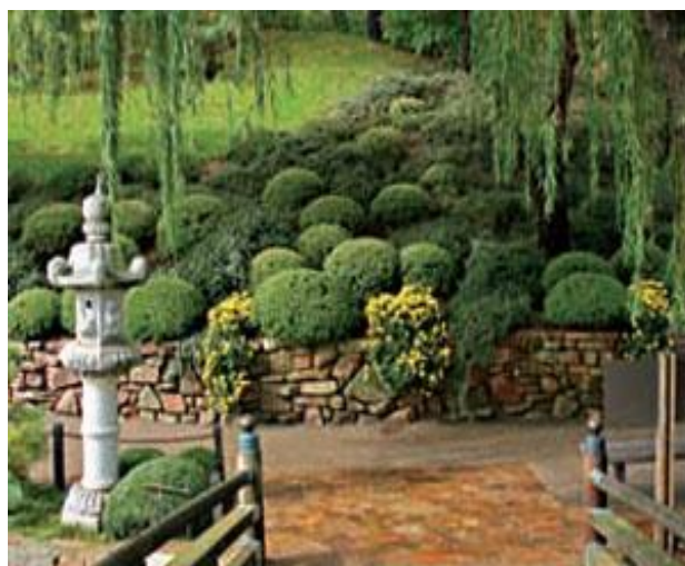
Рисунок 53 – Подпорная стена из камня
