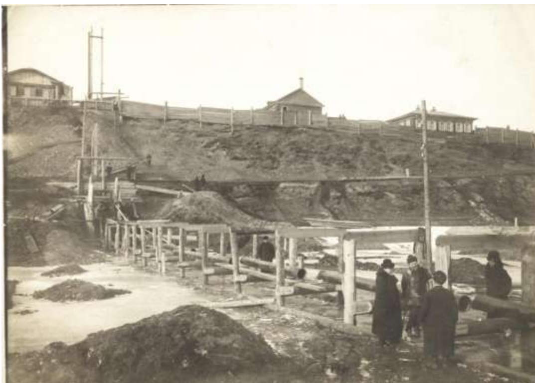
Рисунок 1.3 – Прокладка водопровода в город: слева направо – П.С. Смирнов, Б.Ю. Гетцен и техник Егоров
