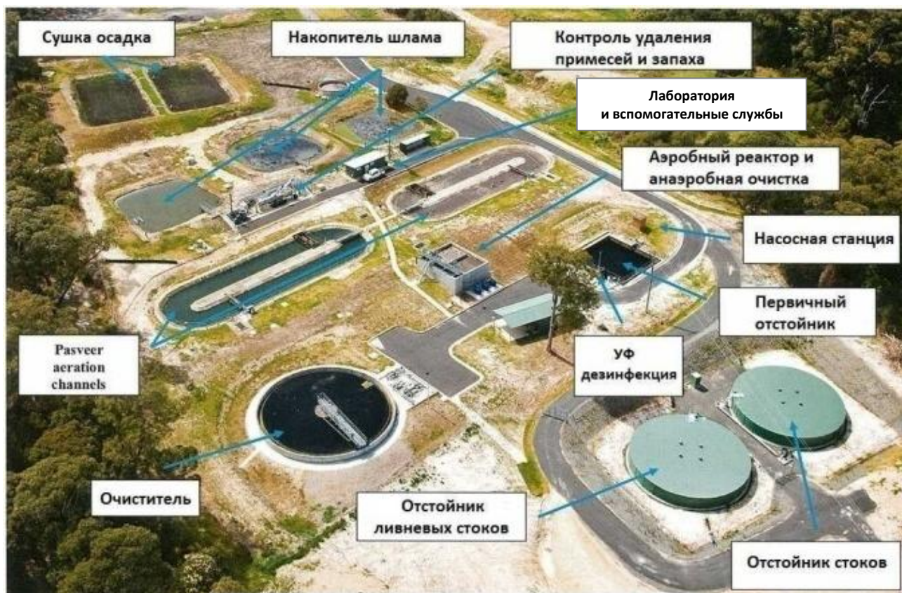
Рисунок 35 – Очистные сооружения сточных вод ( https://stroy-podskazka.ru/ochistka-stochnyh-vod/sooruzheniya/ )
