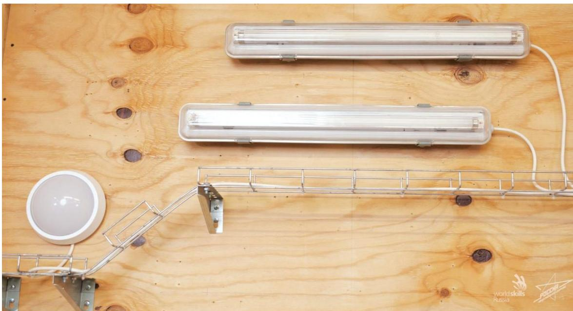
*Рисунок 2 – Вид правильно смонтированных приборов освещения*
