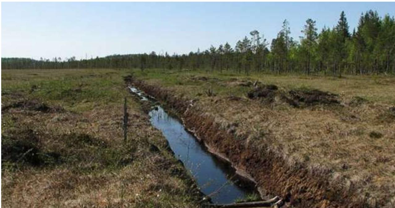
*Рисунок 16 – Осушение при помощи открытого дренажа*
