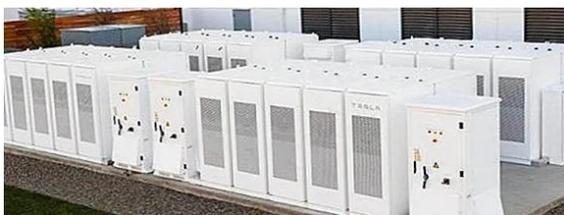
Рисунок 1 – Литий-ионные аккумуляторы Tesla Powerpack 8 МВт ·ч [2]
