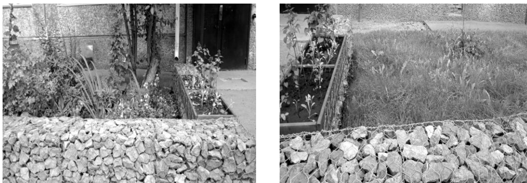
Рисунок 1- Использование габионных конструкций в благоустройстве придомовой территории
