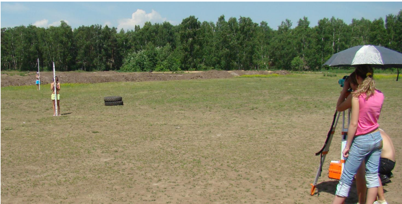
Рисунок 4 – Нивелировка строительной площадки высокоточным электронным нивелиром SDL 50 фирмы SOKKIA
