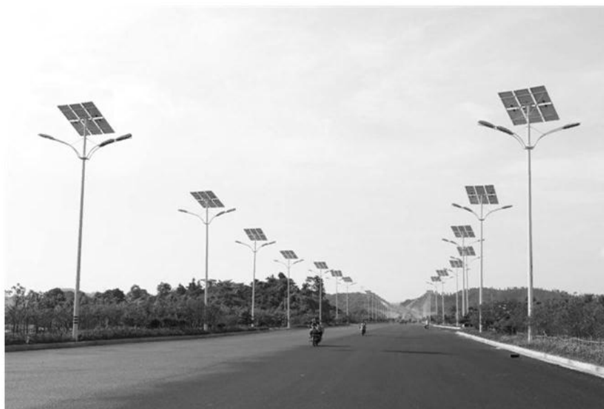
Рисунок 4– Система освещения улицы на солнечных батареях
