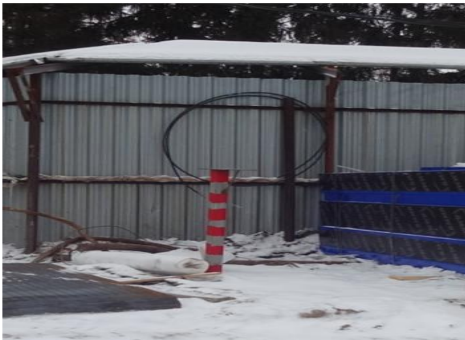
Рисунок 2 – Грунтовой репер со столиком принудительного центрирования (RP4)
