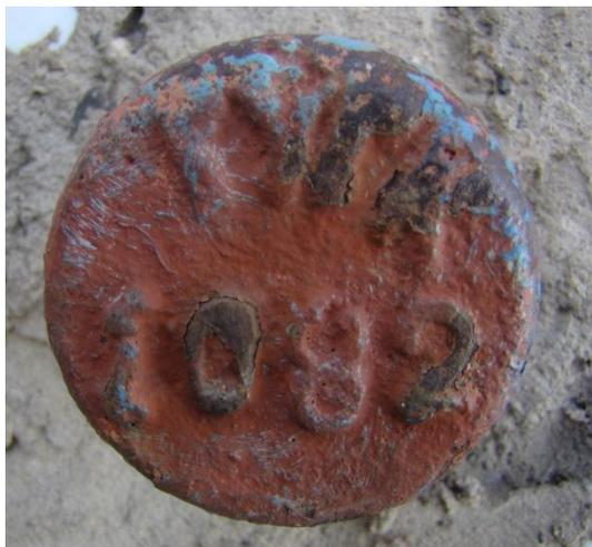
Рисунок 1 – Стенной репер
