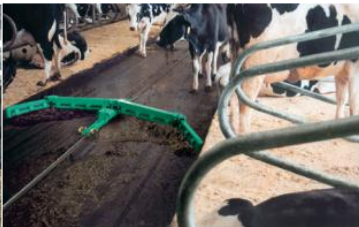
Рисунок 10 – Скреперная установка уборки навоза в коровнике [5]
