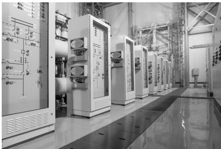
Рисунок 3-Цифровая подстанция «Медведевская»
