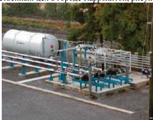
Рисунок 2 - кабельная установка Southwire в г. Карролтон[1]
