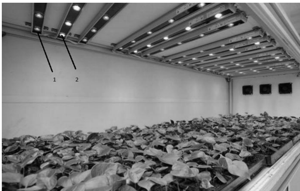
Рисунок 2 – Размещение светодиодных конструкций над рассадой. 1 – светильник с красными светодиодами; 2 – светильник с синими светодиодами
