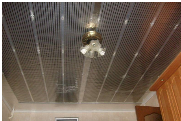
Рисунок 2 – Крепление ПЛЭН на потолок
