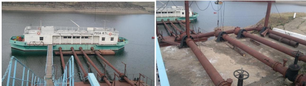
Рисунок 5 – Плавучая насосная станция «Росо - 8» (Новоселовская оросительная система).
