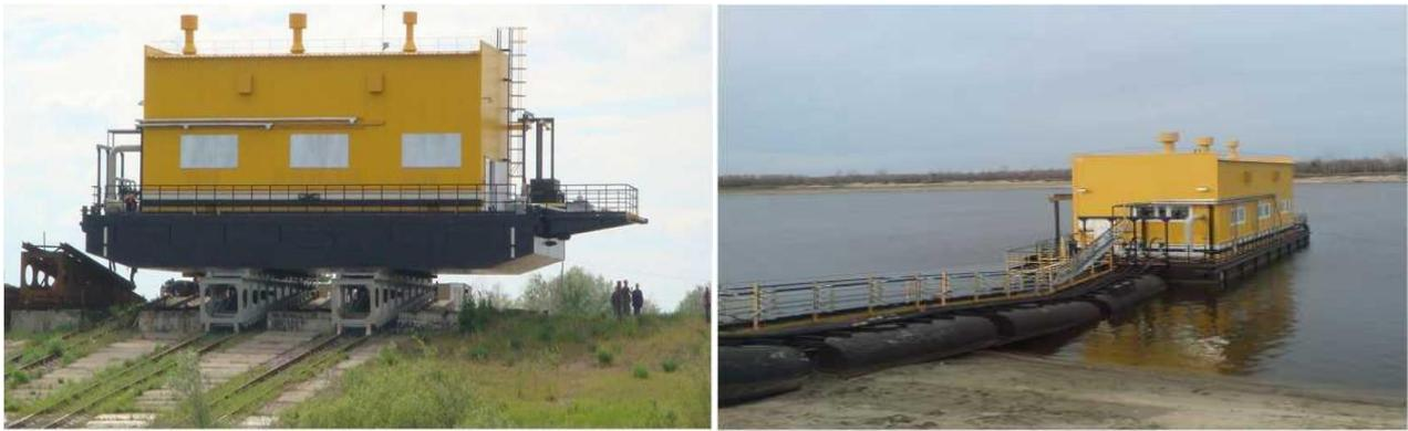
Рисунок 6 – Плавучая насосная станция. а) спуск на воду; б) рабочее состояние.
