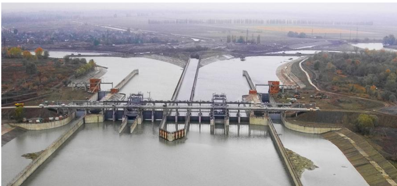
Рисунок 2 – Гидротехнические сооружения Тиховского гидроузла
