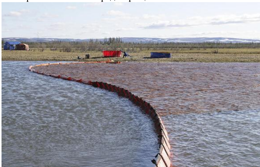
Рисунок 1 – Боновые заграждения на реке Амбарная
