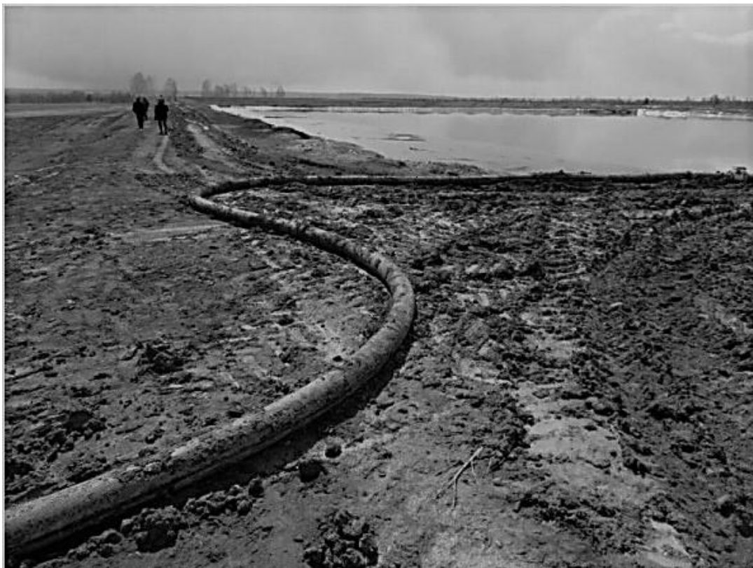
Рисунок 2 – Пруд-накопитель отходов свиного комплекса «Красноярский»
