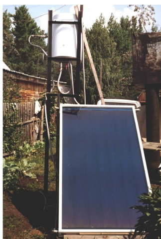
Рисунок 9 – ССГВ на базе гелиоколлектора «Сокол» в СНТ «Нива» Емельяновского района Красноярского края и динамика нагрева теплоносителя в баке аккумулятора
